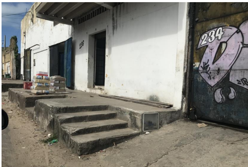
Imagem 05 – Av Zezé Diogo. Fonte: COPROJ-SEINF.
