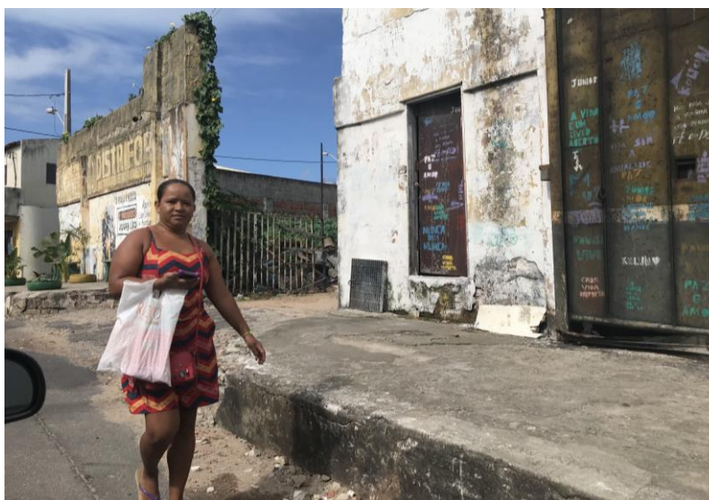
Imagem 04 – Av. Zezé Diogo. Fonte: COPROJ-SEINF.
